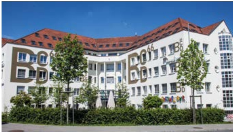
Das Bürogebäude von Netstream befindet sich in Dübendorf.
